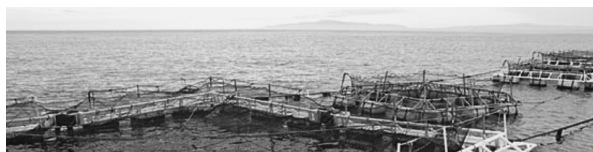
津軽海峡に設置されている生簀
